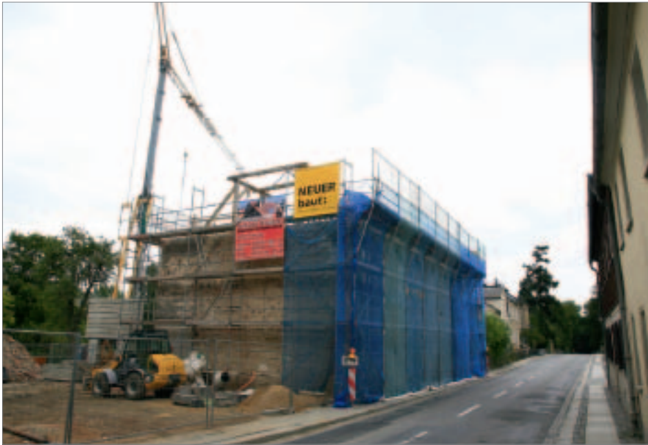
■ Bauarbeiten am neuen Verwaltungsgebäude der Herrnhuter Diakonie in der Zittauer Straße. Foto: Daniel Neuer.
